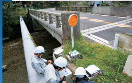
PC橋の補修後モニタリング
