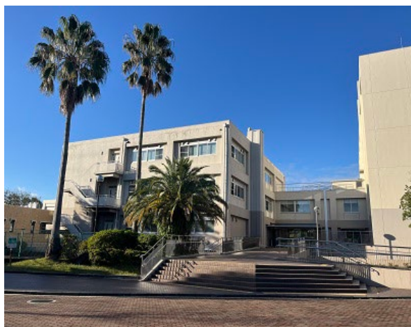
保健管理センター名谷分室
