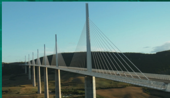
フランスのミヨー高架橋
