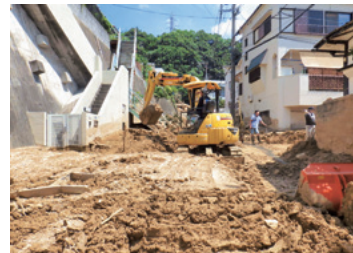
災害時の復旧作業風景
