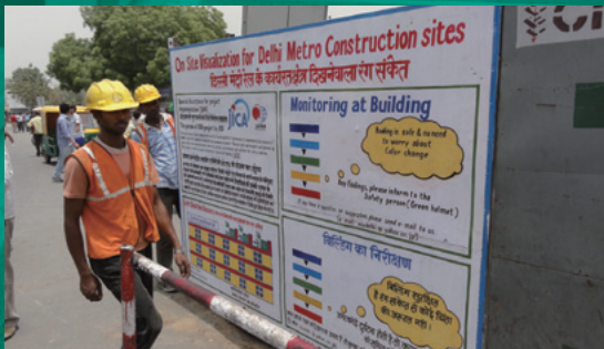
地下鉄工事現場の安全管理システムを周辺住民に情報開示（ニューデリー）
