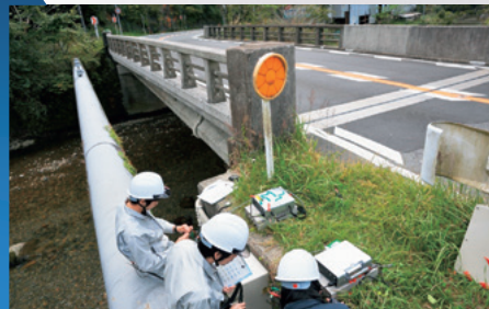
PC橋の補修後モニタリング
