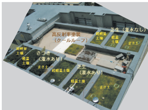
都市構造物の表面被覆技術に関する実験施設(神戸大学内に設置)
