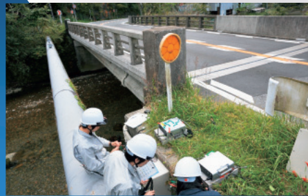
PC橋の補修後モニタリング
