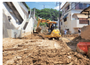
災害時の復旧作業風景
