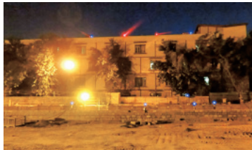
ニューデリーの地下鉄工事現場でのOSV (赤青の光) による安全管理
