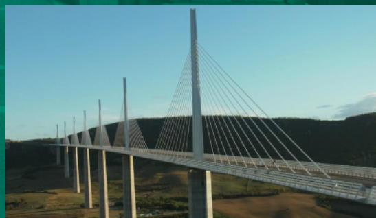
フランスのミヨール高架橋
