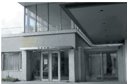
保健管理センター楠分室
