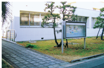
保健管理センター深江分室
