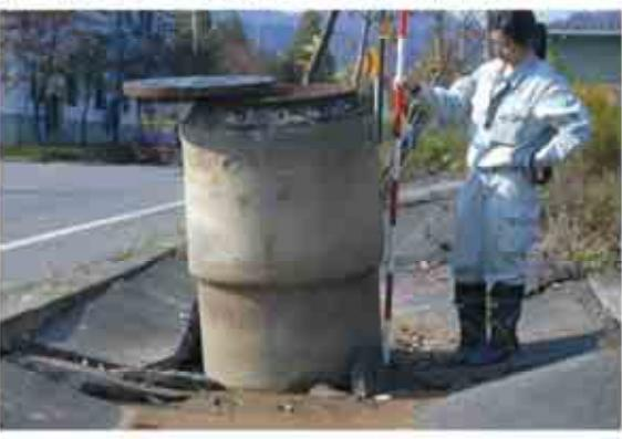
地震の液状化によるマンホールの浮き上がり
