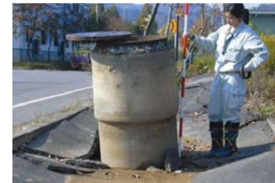
地震の液状化によるマンホールの浮き上がり
