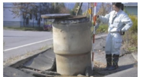
地震の液状化によるマンホールの浮き上がり
