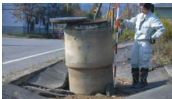
地震の液状化によるマンホールの浮き上がり
