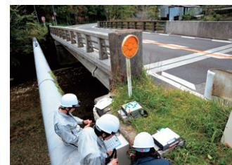
図2：PC橋の補修後モニタリングの状況
