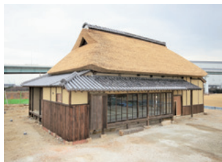
図2：旧小阪家住宅（解体部材から復元した古民家）
