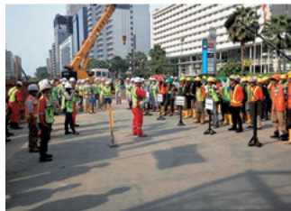
図2：ジャカルタの地下鉄工事でOSV技術を適用
