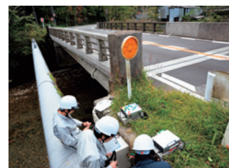
図2：PC 橋の補修後モニタリングの状況
