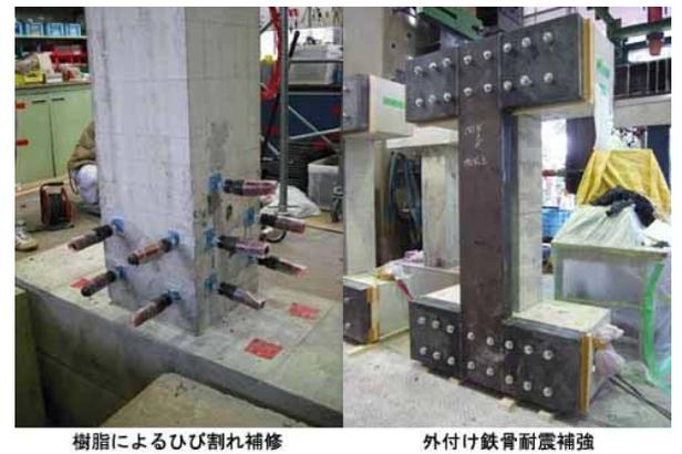
樹脂によるひび割れ補修
